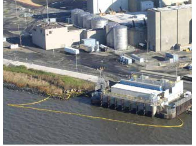
▲ Şekil 13: Bir elektrik santralinin soğutma suyu alma yapısının ön tarafına yerleştirilen perde engel.
