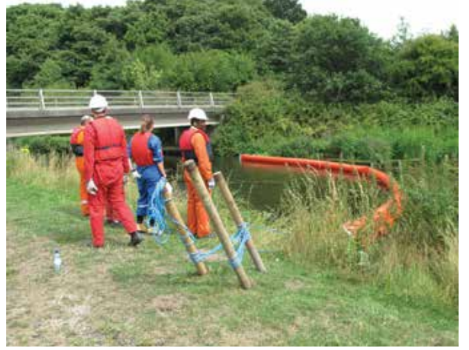
▲ Şekil 17: Ağaçlar veya başka doğal çapaların olmadığı sahil şeridinde engelin yerinde tutulması için palamalarla bağlama kazıkları.
