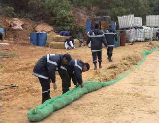
▲ Şekil 20: Ağ ve samandan yapılan eğreti engel. Buna rağmen, birden fazla gelgit döngüsüne dayanması beklenmediğinde, bu su yüzeyinde gelen petrol tabakasının sahil şeridinde yol açacağı kirliliğin azaltılmasına hizmet edebilmektedir.
