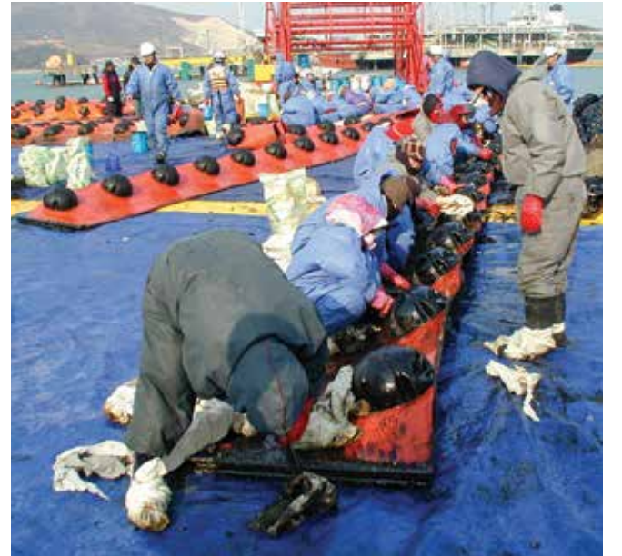
▲ Şekil 6: Çitin harici şamandıralarının arkasında hapsolan petrolün temizlenmesi özellikle güç olabilmektedir.
