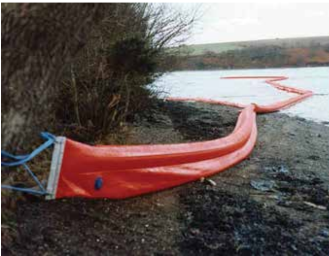
▲ Şekil 18: Bir halice yerleştirilen sahil şeridi sızdırmazlığı sağlayan engel. Alt safra suyu doldurma odaları engelin sular çekildiğinde kıyıya oturmasına olanak sağlayacaktır. Bu örnekte, sahil şeridi sızdırmazlığı sağlayan engel kesitleri havayla şişirilebilir perde engelin kesitlerine bağlanmaktadır.
