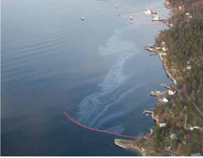
▲ Şekil 14: Petrolün yönünün geri toplanmak üzere kıyıya çevrilmesi için bir çıkıntı olarak kullanılan engel (© Norveç Sahil İdaresi).
