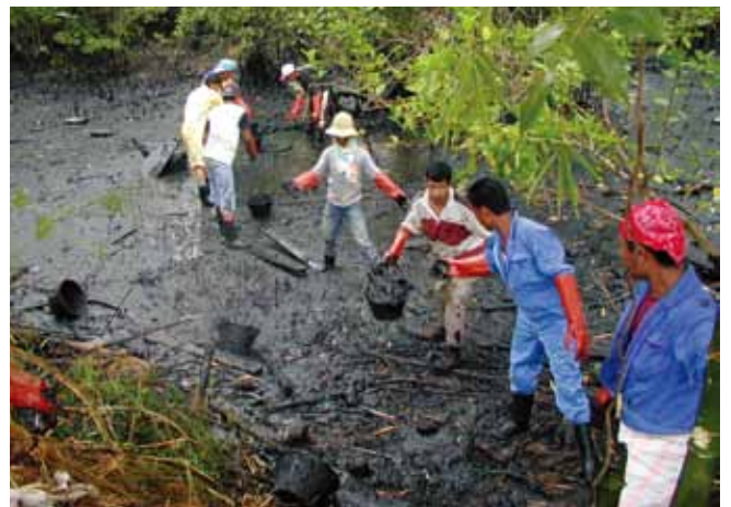
▲ 图 42：应慎重考虑是否需要清除红树林中的油类，以便最大限度地减少对高度敏感的结构造成的额外破坏。
