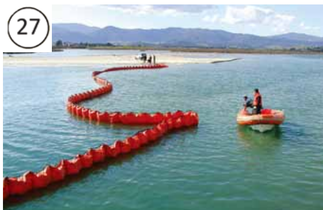
图 5：靠近河口的浮木档栅部署点。布设浮木档栅来让油类偏离可从岸上方便进入的收集点。
