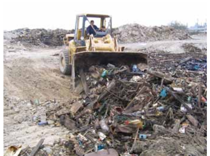
▲ 图 14：在油类上岸前从海岸线清除残片将帮助减少需要弃置的沾油材料的数量。
