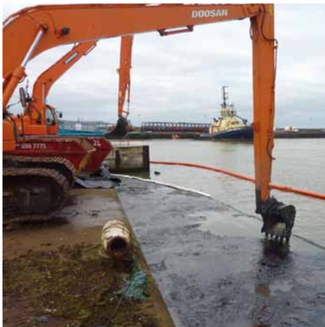
▲ 图 5：被用来从港口区域回收油类的土木工程机械设备。在这种情况下，水温低于油类的倾点，导致油类变成半固态，因而无法使用撇浮装置加以回收。
