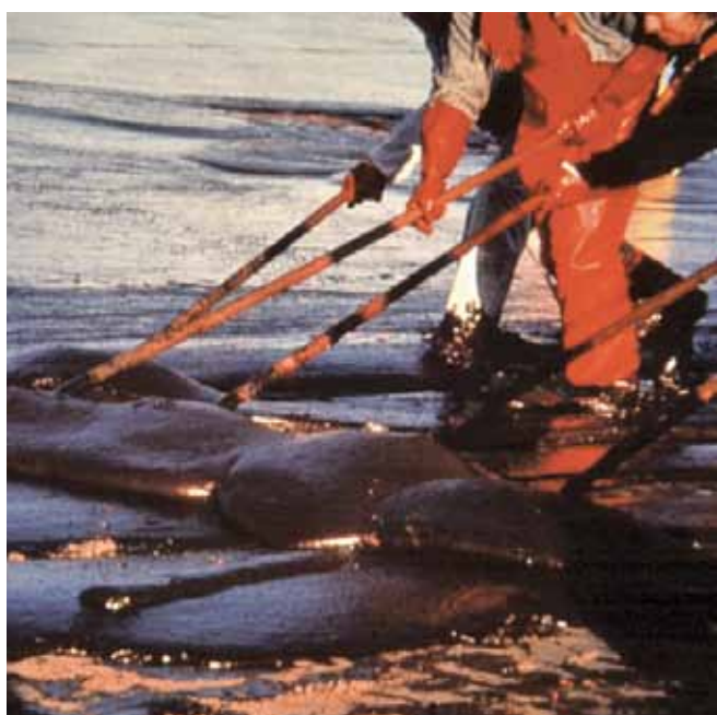
▲ 图 12：沿结构紧密的沙滩刮原油，以便将它们收集到沟渠中，然后用吸油卡车加以回收以便接下来运往处置场所。
