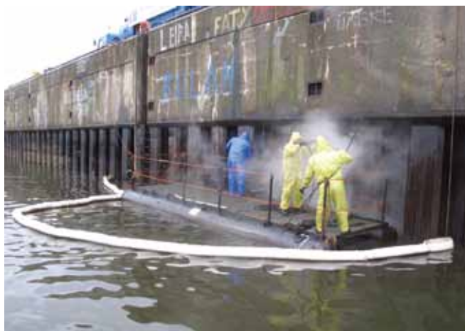
▲ 图 30：正在从一个小筏子上对沾油的桩式建筑和临坞岸壁进行高压洗涤。释放出来的油类在吸油栅栏中进行回收。
