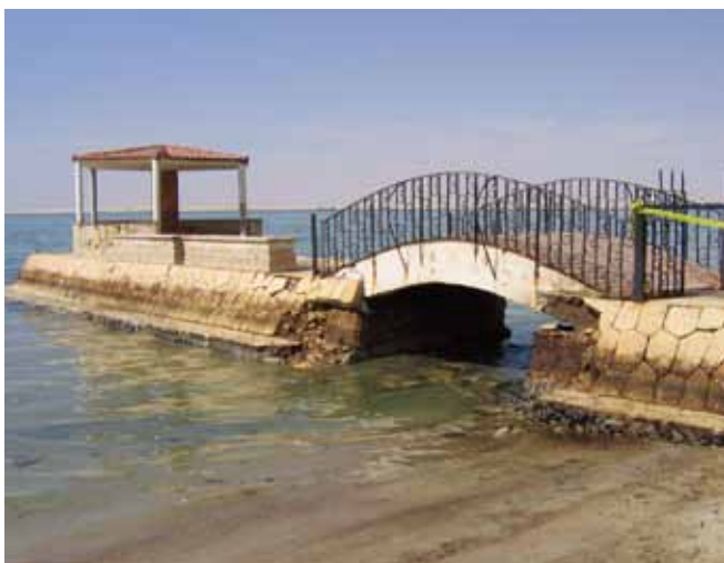
▲ 图 14：石堤上的轻度油渍。可能很容易将这种现象与藻类生长相混淆。
