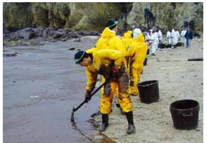
▲ 图 38: 人工从粗沙沙滩上回收已经乳化的燃油。
