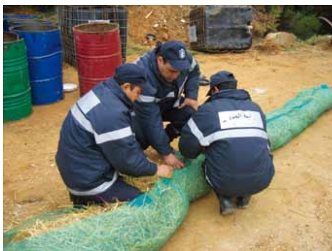
▲ 图 2：使用禾秆和编网制作的简易吸油浮木档栅。这种浮木档栅价格便宜，而且易于制作，可以在部署到合适区域时提供有效的短期保护。
