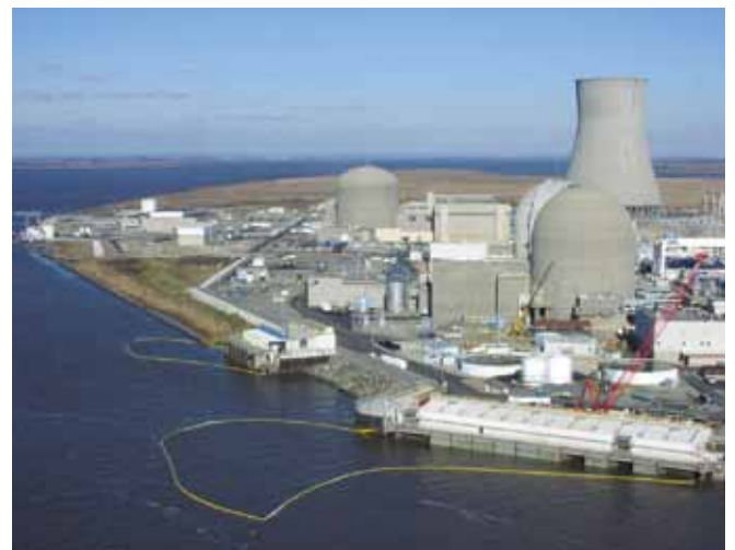
▲ 图 7：应该保护进水口，以防止油类影响热交换装置，此类装置很难清理，可能会导致设施关闭。
