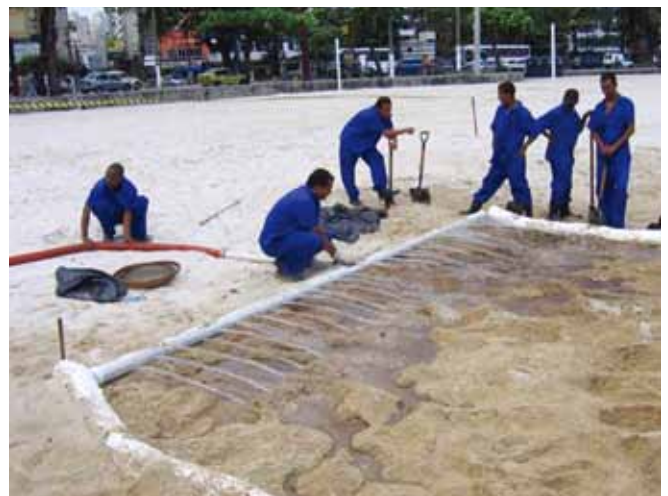
▲ 图 1：通过低压冲洗就地清洁沾油砂粒，并相应地部署吸油浮木档栅来捕获释放出的油类。
