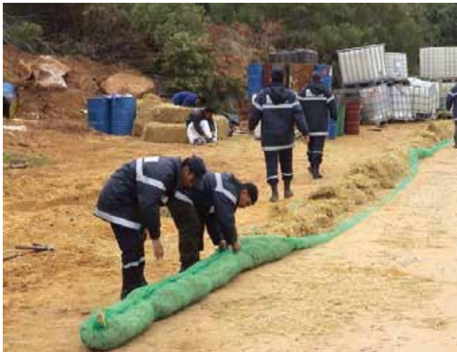
▲ 图 20：就地取材用渔网和稻草制成的栅栏。虽然这种栅栏的使用寿命预计不能维持一个潮汐周期以上，但可以使用它来减少漂来的浮油对海岸线造成的污染。
