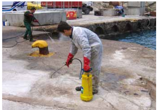
▲ 图 23：先对油渍施用海岸线化学清洗剂，然后再对其进行高压洗涤。
