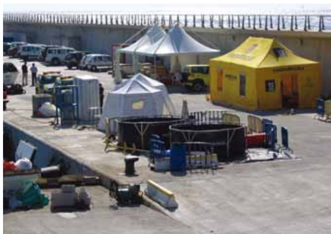
▲ 图 45：在工作现场附近搭建的临时建筑物为工作人员提供膳食和卫生设施。
