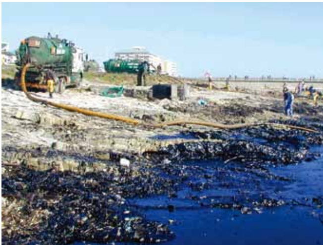
▲ 图 8: 由于真空系统随处可得, 因此这些设备是回收海岸线上或海岸线附近油类的理想之选。
