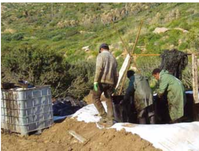
▲ 图 16：回收的溢油吸收丝团悬挂在柱子上，以让油流入容器中，从而最大限度减少废物中的游离油量。
