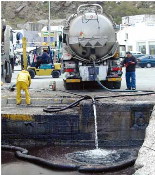
▲ 图 15: 在吸油卡车中沉淀和分离回收的含油水分后, 将水轻轻倒入泄漏区域。
