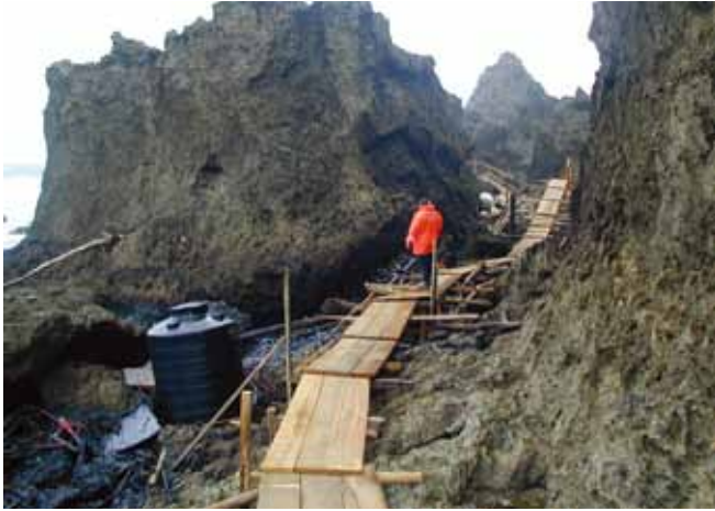
▲ 图 35: 为了最大限度地减少工人在多岩石海岸线上作业时所面临的危险, 可以搭建临时的过道。
