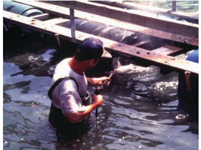
▲ Figura 11: las instalaciones de acuicultura pueden limpiarse in situ mediante lavado a presión.
