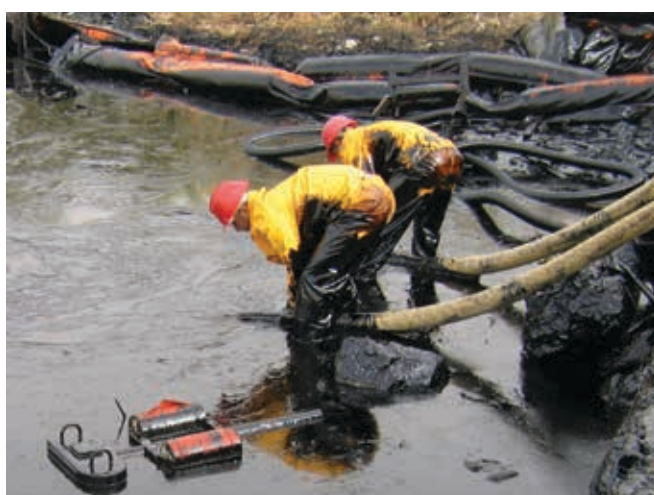
▲ Figura 10: trabajadores sitúan directamente en los hidrocarburos una manguera conectada a una bomba de aspiración. En este caso, se ha retirado el pequeño accesorio vertedero para permitir el flujo de los hidrocarburos viscosos hasta la manguera, lo que puede provocar un mayor arrastre de agua.
