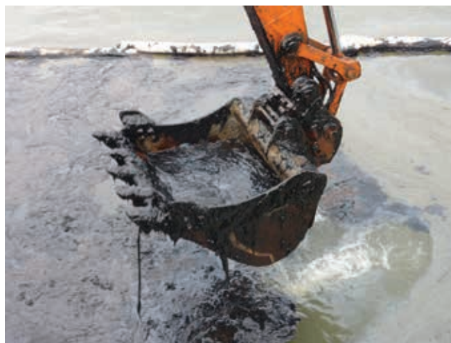
▲ Figura 21: uso de una excavadora para recolectar fueloil muy viscoso. La concentración de hidrocarburos recolectados se optimizó al ordenar al operario que mantuviera la pala por encima de la superficie del agua durante un breve periodo de tiempo para permitir la evacuación del agua arrastrada. Esto redujo los costes de eliminación posteriores a cambio de reducir la eficiencia de recolección.
