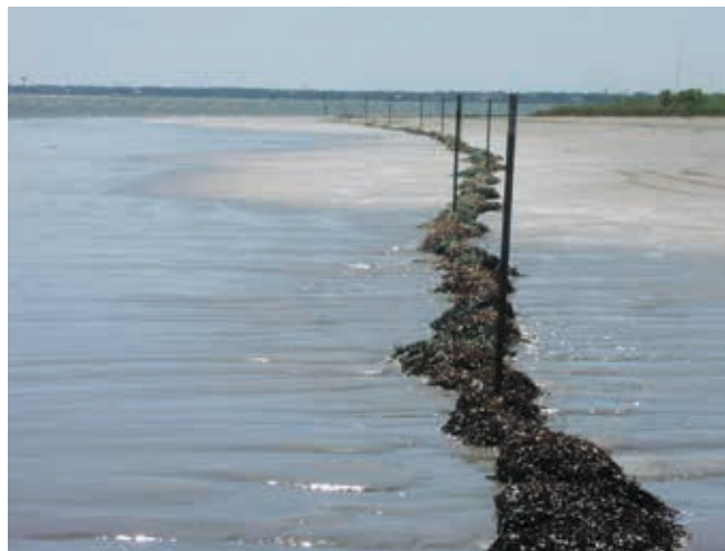
▲ Figura 7: trampa atada a través de un estuario para capturar hidrocarburos flotantes. La estructura abierta y el gran área superficial del material son particularmente adecuados para la recolección de hidrocarburos viscosos.
