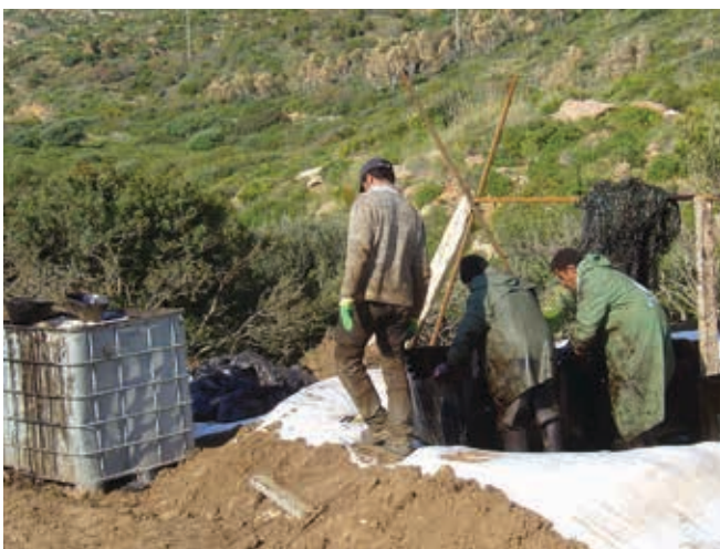
▲ Figura 16: trampa adsorbente recuperada, colgada de una pértiga para permitir que los hidrocarburos se introduzcan en un contenedor y minimizar la cantidad de hidrocarburos libres en el residuo.
