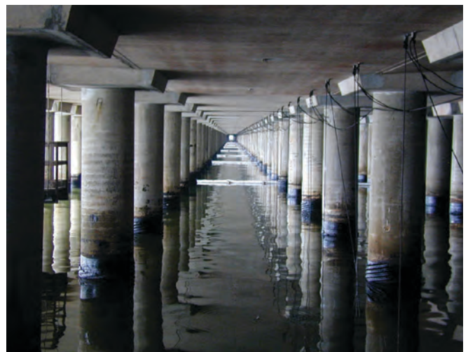
▲ 그림 5: 부두 아래는 윗부분의 공간이 좁고 통풍이 어려워 세척 업자들이 접근하기가 어렵고 위험하다.
