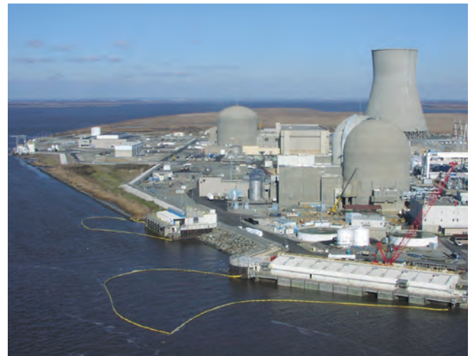
▲ 그림 7: 열 교환기는 세척이 어렵고 시설의 가동 중지가 일어날 수 있으므로 취수설비가 기름에 오염되지 않도록 보호해야 한다.
