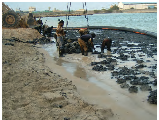
▲ 그림 19: 회수 축진을 위한 팽창식 오일펜스에 의해 해안가에서 포집된 반고체형 기름.
