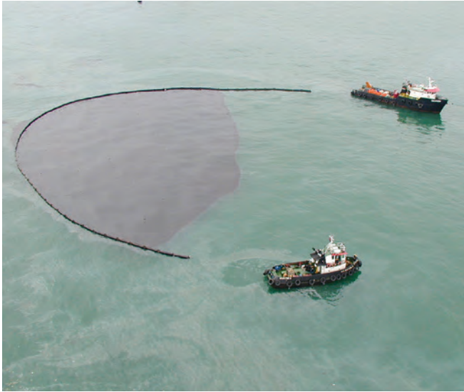
▲ 그림 8: 중질 원유의 포집을 위해 선박 두 척이 U자형으로 예인하고 있는 팽창식 오일펜스. 기름을 회수하면 작업이 성공적으로 완료된다.
