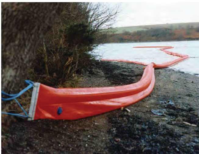
▲ 그림 18: 하구에 설치되어 있는 해안용 오일펜스. 아래쪽 격실에 물이 채워져 있는 발라스트는 간조 때 오일펜스가 바닥에 안착되도록 한다. 이 경우 해안용 오일펜스의 섹션은 팽창식 커튼형 오일펜스의 섹션과 연결된다.
