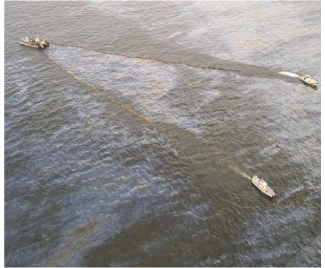
▲ 그림 9: 선박 두 척이 V자형으로 예인하고 있는 커튼형 오일펜스. 정점 부분에 별도의 회수선이 작업하고 있다.
