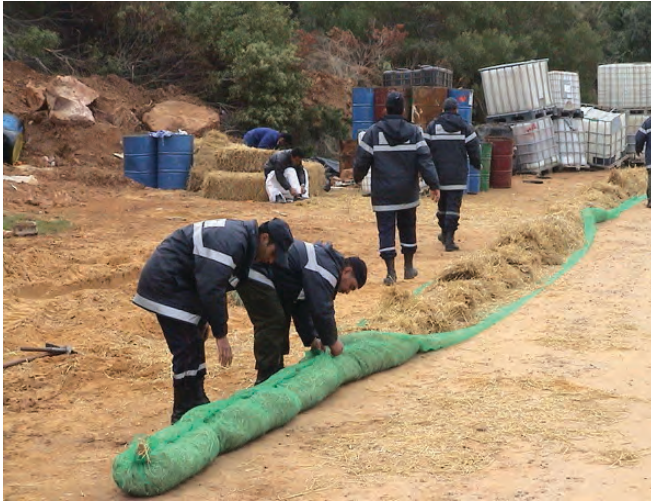
▲ 그림 20: 그물과 짚을 재료로 즉석에서 제작된 오일펜스. 1회 이상의 조수 주기를 견디지는 못하지만 유입되는 부유 기름으로 인한 해안가 오염을 줄일 수 있다.
