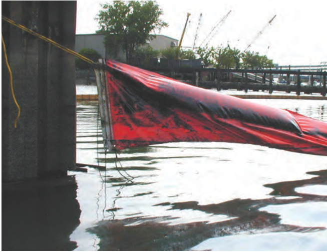
▲ 그림 16: 길이가 불충분한 계류로프를 사용하여 간조 때 오일펜스가 로프에 매달림으로써 기름이 유실되고 있다. 조수 주기 전체에 걸쳐 오일펜스의 설치 위치를 효과적으로 유지하려면 로프를 정기적으로 조정해야 한다. 이때 슬라이드형 계류 시스템이 더 적절할 수 있다.
