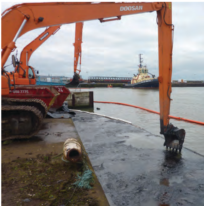
▲ 그림 5: 항내에서 건설장비를 회수작업에 동원, 이 경우 수온이 기름의 유동점 이하로 내려가고, 반고체상태로 있기 때문에 유회수기 사용이 곤란함
