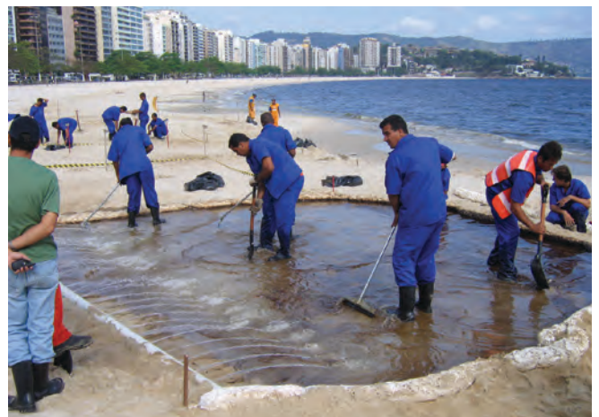
▲ 그림 16: 모래 해변에 침투한 기름은 파이프를 통해서 공급되는 저압플러싱으로 제거 될 수 있다. 저질에서는 모래와 기름이 분리되도록 수작업으로 교반한다. 그리고 이 기름은 작업구역내에서 흡착분으로 회수된다.
