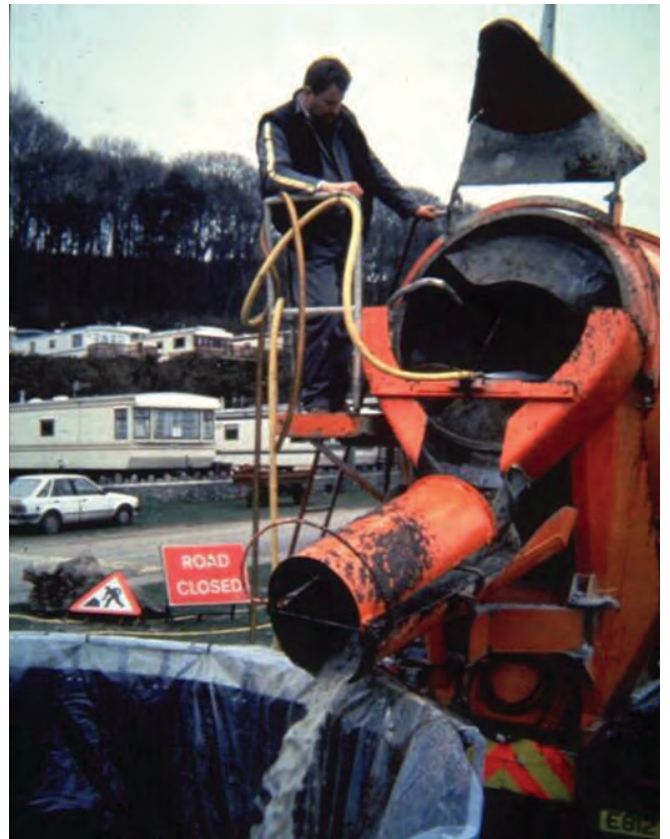
▲ 그림 24: 조약돌을 세척한 후 콘크리트 혼합 차량으로부터 폐수가 흘러나오고 있다.
