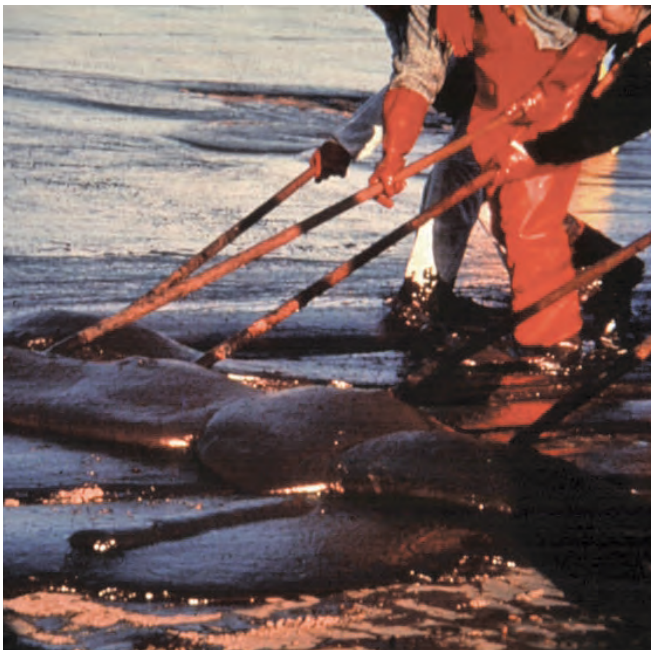
▲ 그림 12: 단단한 모래해안의 원유는 도랑쪽으로 모으고 진공트럭을 이용하여 회수한다.
