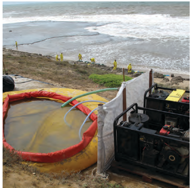
▲ 그림 22: 원거리 바위해안의 고압 세척. 바닷물을 펌프를 이용하여 임시저장탱크로 이송하고 고압세척기에 사용된다.
