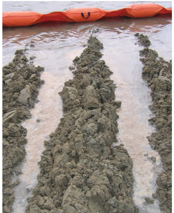
▲ 그림 25: 오염된 해변의 저질을 표면으로 노출되도록 한다. 기름은 조류에 의해 해안가로 모이게 된다.
