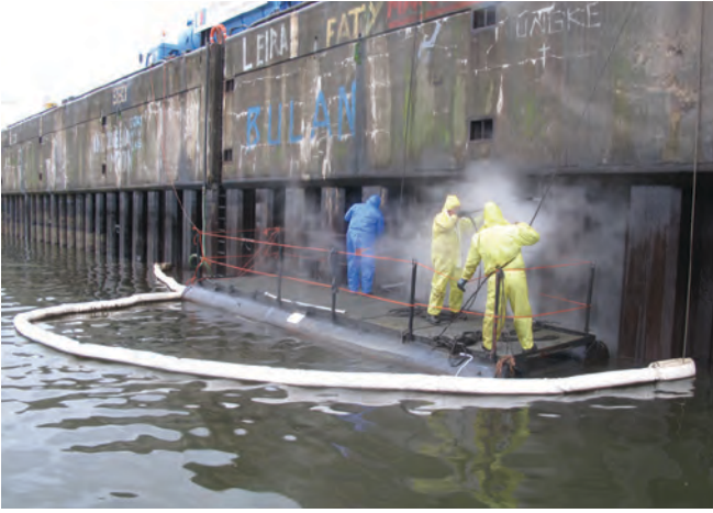
▲ 그림 30: 작은 뗏목을 이용하여 오염된 방파제를 압력 세척한다. 떨어져 나온 기름은 흡착분을 이용하여 회수한다.
