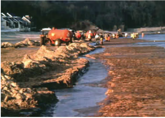
▲ 그림 4: 농업용 진공 탱크를 이용하여 도랑으로 모아진 기름을 회수.
