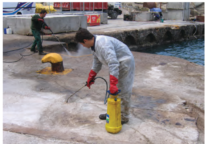
▲ 그림 23: 고압세척 후 해안 세척제를 사용하여 기름 얼룩을 제거한다.
