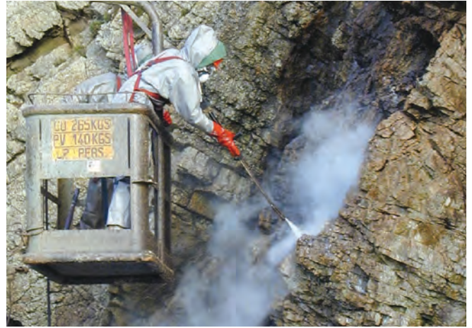
▲ 그림 21: 관광 위락시설 해안의 절벽을 압력세척하고 있다. 기름은 폭풍에 의해 해안 절벽의 높은 곳을 오염 시킬 수 있고 방제작업을 수행하지 않으면 오랫동안 지속 될 수 있다.
