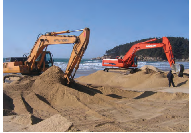
▲ 그림 18: 경미하게 오염된 모래를 파도지역으로 옮겨 조석의 차를 이용하는 세척한다.
