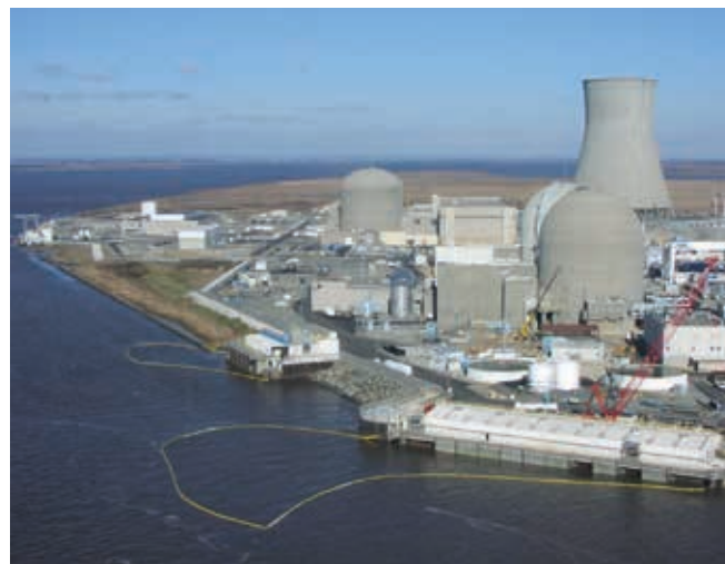
▲ Рис. 7: Необходимо принять меры для защиты водозаборных сооружений и предотвращения попадания нефти в теплообменники, которые сложно поддаются очистке. Их выход из строя может привести к прерыванию эксплуатации объекта.
