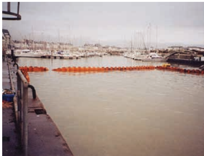
▲ Рис. 2: Развертывание боновых заграждений у входа в яхтенную или рыболовную гавань может оказаться неэффективным из-за риска повреждения бонов судами при входе и выходе.
