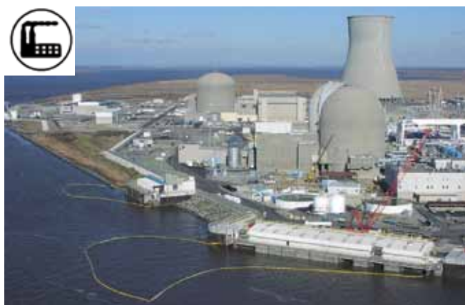
الشكل رقم 6: محطة طاقة كهربائية لها مدخل للمياه في المقدمة. تم وضع العديد من حواجز التطويق الطافية للحيلولة دون دخول النفط.
