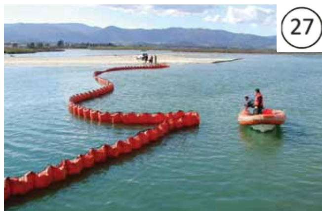
الشكل رقم 5: نشر حاجز تطويق طاف بالقرب من فحة نهر. يضبط الحاجز بحيث يحرف النفط إلى نقطة تجميع يمكن الوصول إليها جيداً من الشاطئ.
