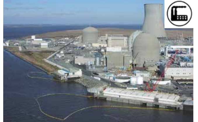
Şekil 6: Ön tarafında bir su alma yapısı bulunan elektrik santrali. Petrolün girişinin engellenmesi için bazı saptırıcı serenler yerleştirilmiştir.
