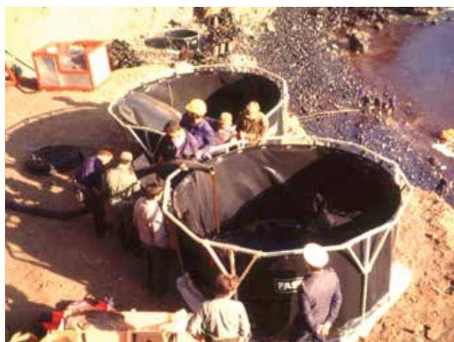
▲ Рис. 28: Эмульгированная топливная нефть, собранная с береговой линии скиммерами и насосами в емкости для временного накопления, размещенными на береговых скалах.
