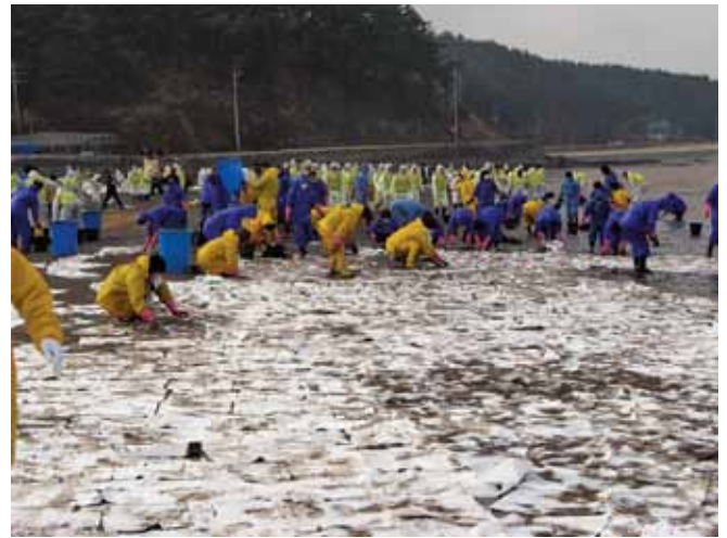
▲ الشكل رقم 9: استخدام مادة ماصة على نطاق واسع لاستعادة النفط على شاطئ رملي صلب. يجب أن يكون استخدام المادة الماصة مناسباً لحجم التلوث، وأن يقدم فائدة ملحوظة للاستجابة وألا يزيد حجم النفايات المطلوب التخلص منها دون داع.
