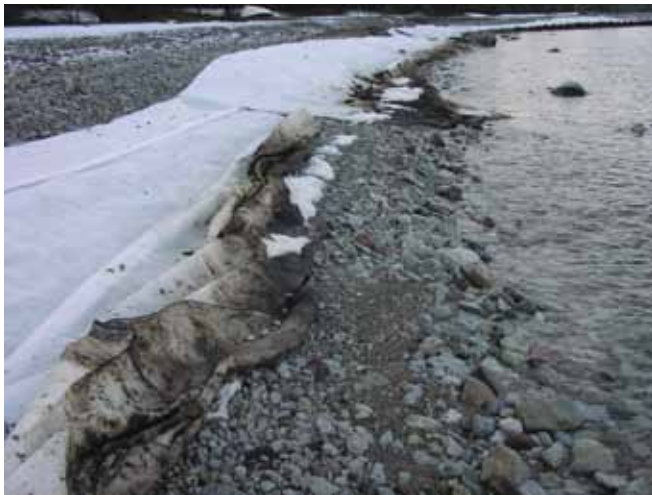
الشكل رقم 5: تتميز المواد الماصة المسطحة والمتصلة، مثل هذا اللوح الموضوع على الساحل، بارتفاع النسبة بين مساحة السطح إلى الحجم. يجب تحقيق التوازن بين استخدام المادة الماصة بهذا الأسلوب على نطاق واسع وبين توليد أحجام كبيرة من النفايات الملوثة التي يمكن أن تكون ملوثة بالنفط.
