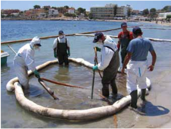
الشكل رقم 1: حاجز تطويق طاف ماص من البولي بروبيلين يستخدم لتجميع النفط المنبعث أثناء عمليات الغسيل بالماء.
