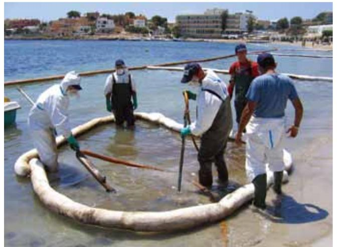
▲ 图 1：用于在冲洗作业期间收集油类的聚丙烯吸油浮木档栅。
