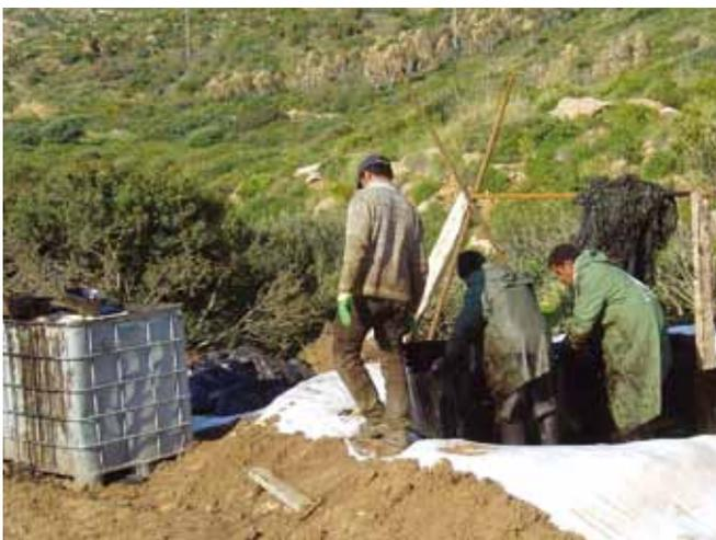
▲ 图 16：回收的溢油吸收丝团悬挂在柱子上，让油流入容器中，从而最大限度减少废物中的游离油量。
