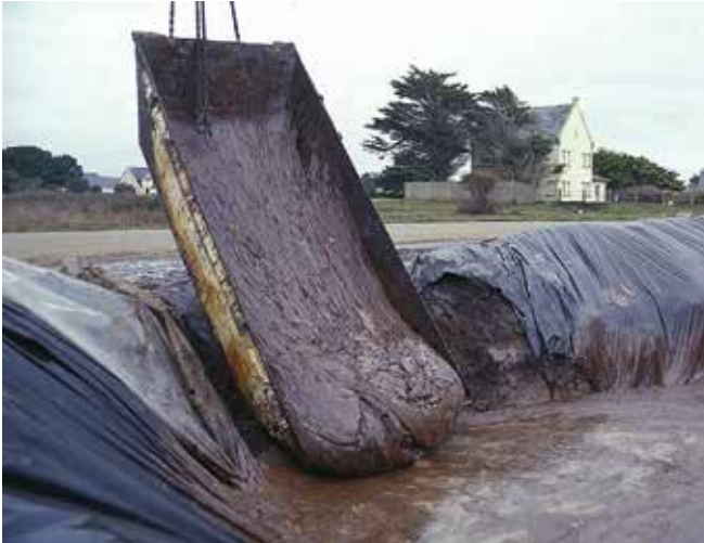
▲ Şekil 11: Kaplanmış bir geçici depolama çukurunun içerisine sütsüleşmiş yağ yakıtın çö konteynirıyla boşaltılması.
