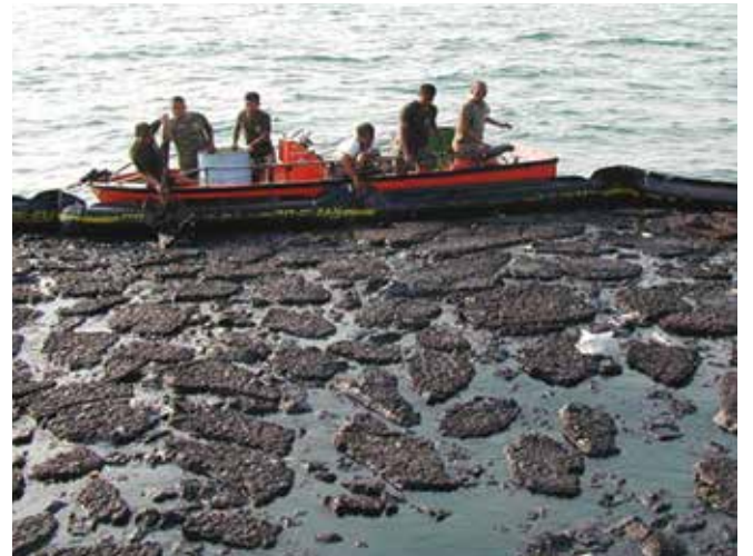
▲ Şekil 6: Bir engel içerisine kontrol altına alınan yarı katı petrol. Petrolün pompalanmasında yaşanan güçlükler mevcut bertaraf yollarını sınırlandırabilmektedir.
