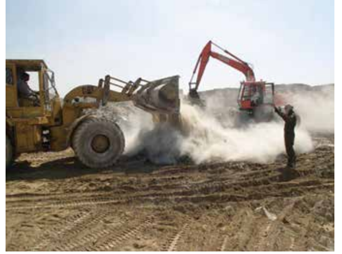
▲ Şekil 18: Sönmemiş kireç kullanılarak yağlı atığın kararlı hale getirilmesi.
