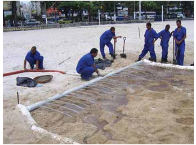
▲ Şekil 1: Serbest kalan petrolün yakalanması için uygun bir şekilde plana göre yerleştirilmiş emici maddeden engelle birlikte, düşük basınçlı suyla yıkanarak petrol bulaşmış olan toprağın yerinde temizlenmesi.
