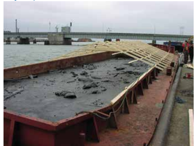
▲ Şekil 10: Bir mavnada depolanan geri toplanmış petrol. Yağmur suyu girişinin önlenmesi için bir örtü gereklidir.
