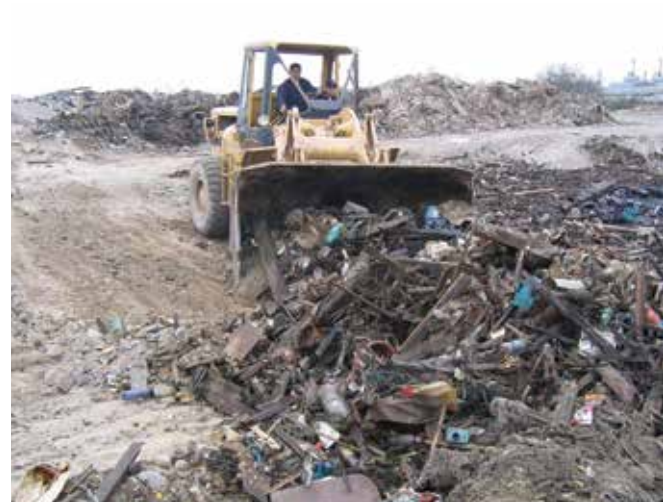
▲ Şekil 14: Döküntünün petrol karaya oturmadan önce kaldırılması bertaraf gerektiren petrol bulaşmış malzemenin miktarının azaltılmasına yardım edecektir.
