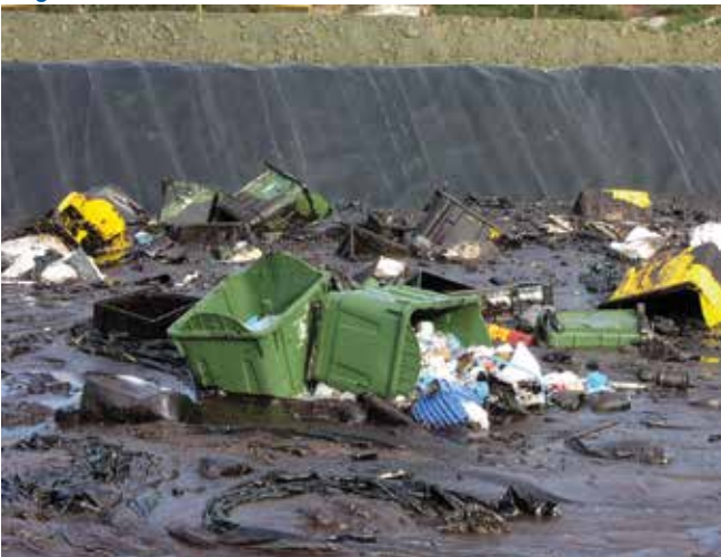
▲ Şekil 9: Yetersiz bir şekilde tecrit edilmiş atık içeren, ayırma ve işleme için büyük ek çaba gerektiren iyi bir şekilde kaplanmış çukur.
